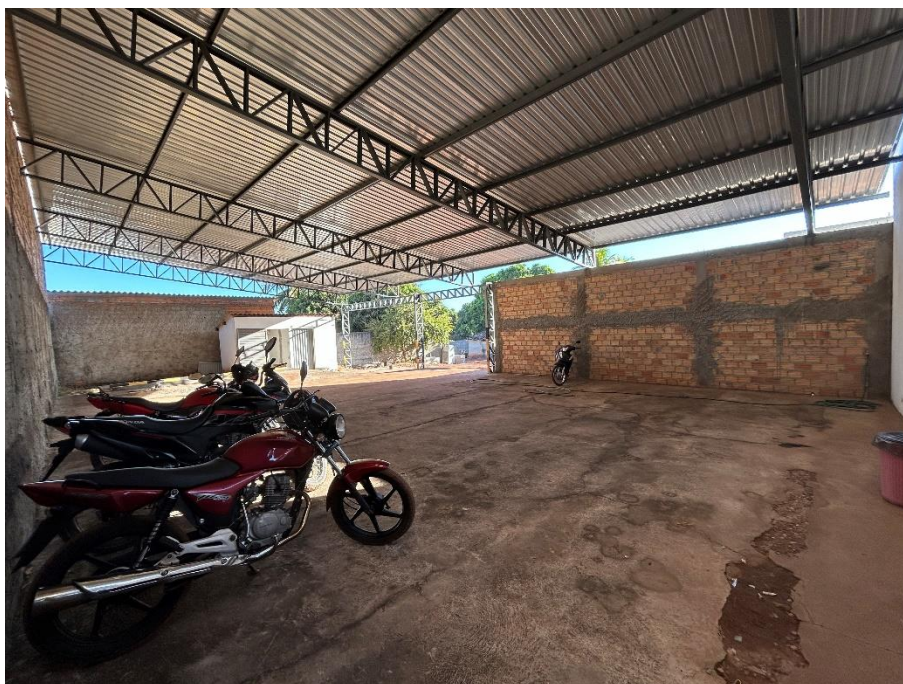
Foto 11. Prédio da CRT em Torixoréu – Barracão de vistoria - Vista a partir dos fundos da edificação. Foto em 22/08/2024.
