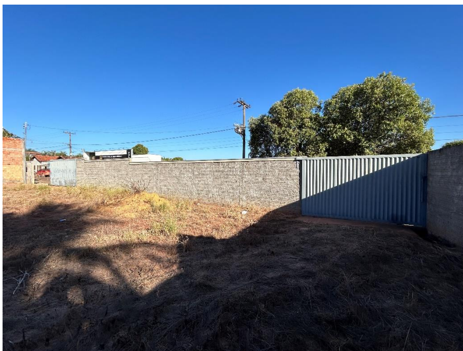
Foto 16. Prédio da CRT em Torixoréu – Pátio no fundo da edificação – Vista dos portões, sendo um eletrônico de acesso ao barracão de vistoria. Foto em 22/08/2024.
