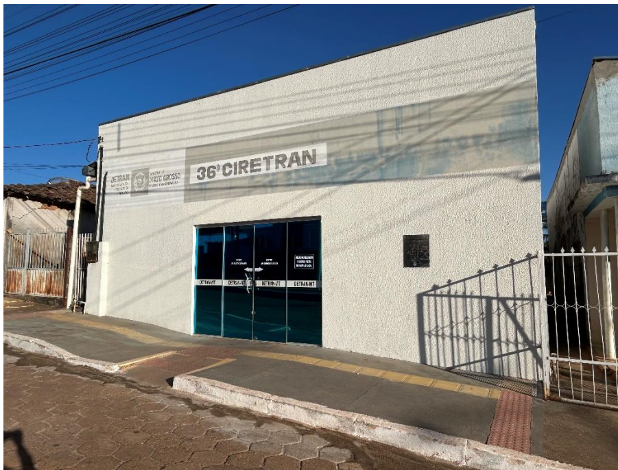
Foto 1. Prédio da CRT em Torixoréu – Vista da fachada a partir do logradouro. Foto em 22/08/2024.
