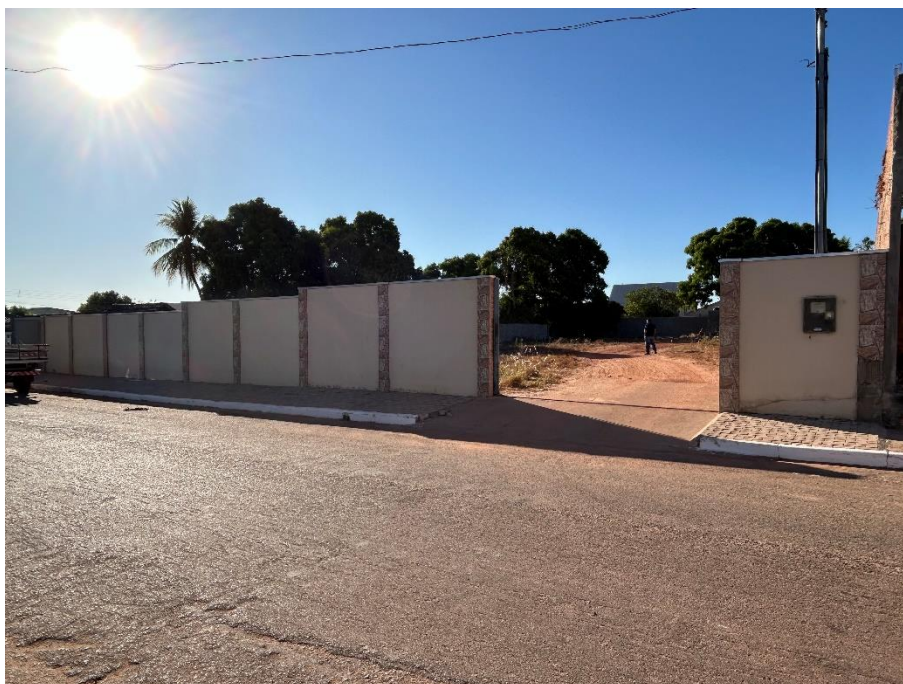
Foto 17. Prédio da CRT em Torixoréu – Vista do acesso ao barracão de vistoria a partir da Rua Mato Grosso. Foto em 22/08/2024.
