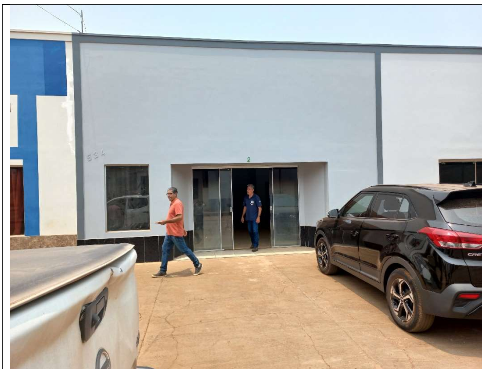
Foto 5. Vista frontal do imóvel a ser locado para complementação da CRT em Aripuanã – a partir da porta de acesso principal da edificação. Foto em 25/09/2024.
