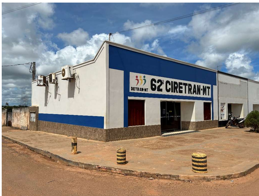
Foto 2. Prédio da CRT em Aripuanã – Vista da fachada da edificação e do imóvel a ser locado a partir do logradouro. Foto em 25/09/2024.
