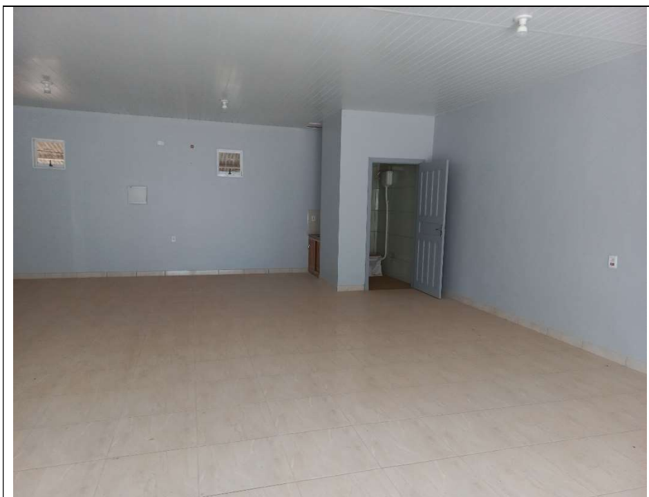
Foto 6. Salão comercial para locação da CRT em Aripuanã – Vista interna da edificação. Foto em 25/09/2024.
