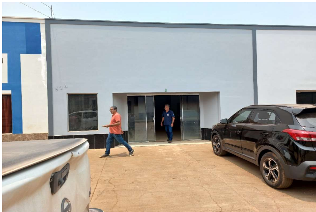
Foto 1. Prédio da CRT em Aripuanã – Vista frontal da edificação a partir do logradouro. Foto em 25/09/2024.
