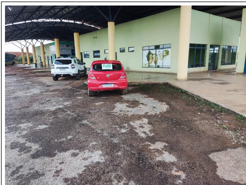
Foto 5. Prédio para locação em Paranatinga – Fachada vista a partir do local da vistoria. Foto em 14/03/2024.
