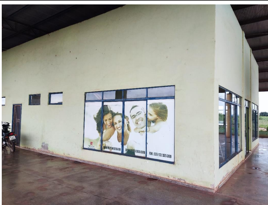
Foto 3. Prédio para locação em Paranatinga – Fachada lado esquerdo. Foto em 14/03/2024.
