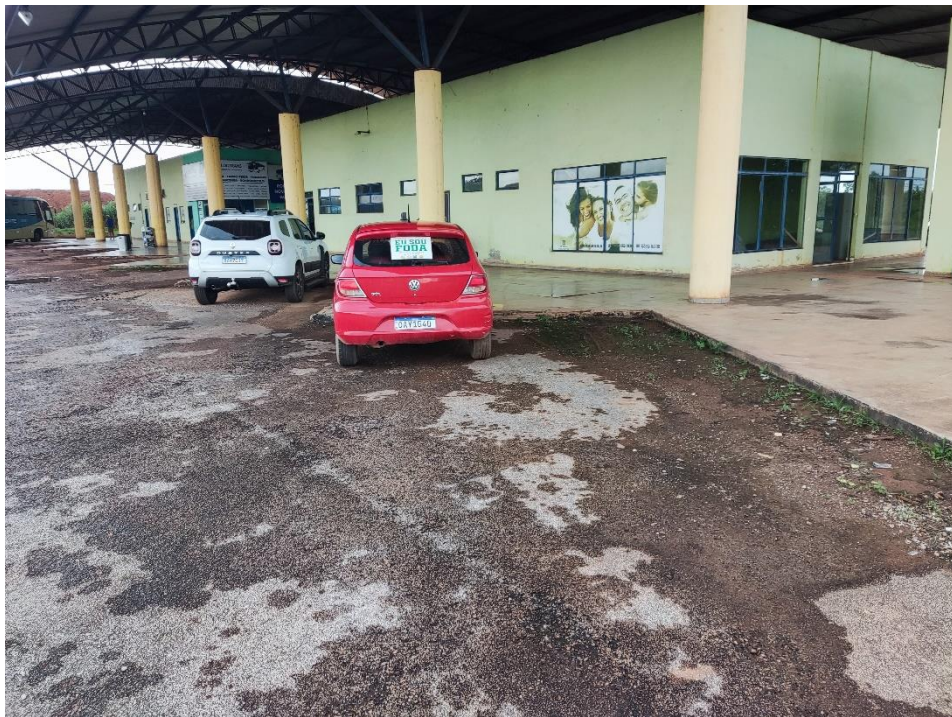
Foto 1. Prédio para Locação em Paranatinga– Vista frontal da edificação a partir do logradouro. Foto em 14/03/2024.
