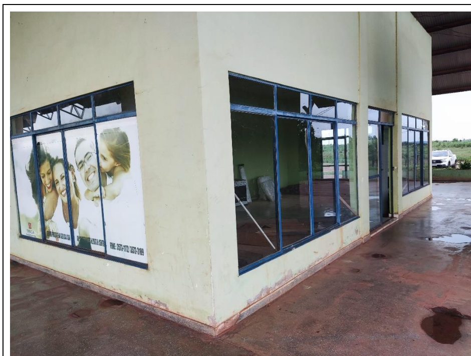
Foto 6. Prédio para locação em Paranatinga – Fachada - Vista da porta. Foto em 14/03/2024.
