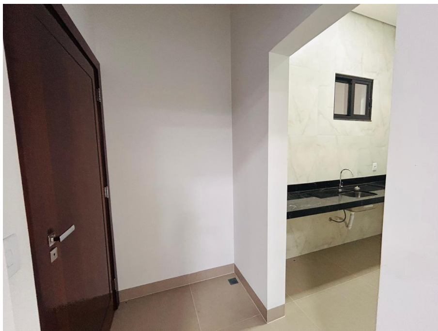
Foto 18. Prédio para locação da vistoria veicular da CRT em Sinop/ MT – Pavimento térreo - Vista da copa/ cozinha a partir do hall de acesso. Foto em 04/02/2026.
