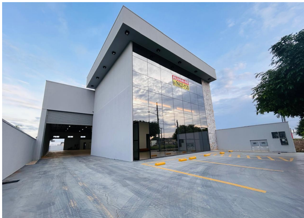
Foto 1. Prédio para locação da vistoria veicular da CRT em Sinop/ MT – Vista frontal da edificação a partir do estacionamento. Foto em 04/02/2026.
