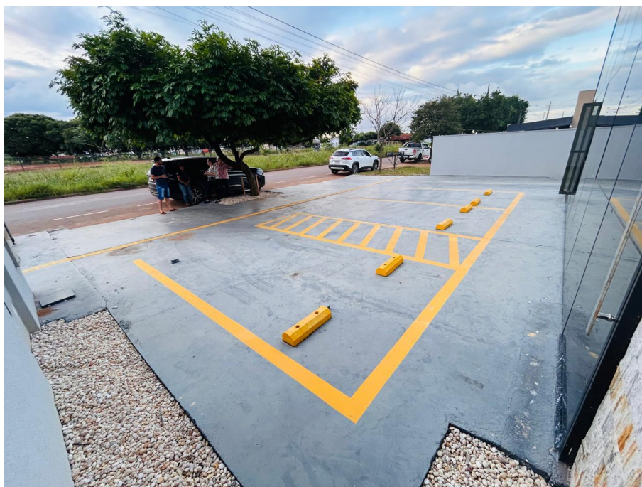
Foto 5. Prédio para locação da vistoria veicular da CRT em Sinop/ MT – Vista do estacionamento do imóvel. Foto em 04/02/2026.
