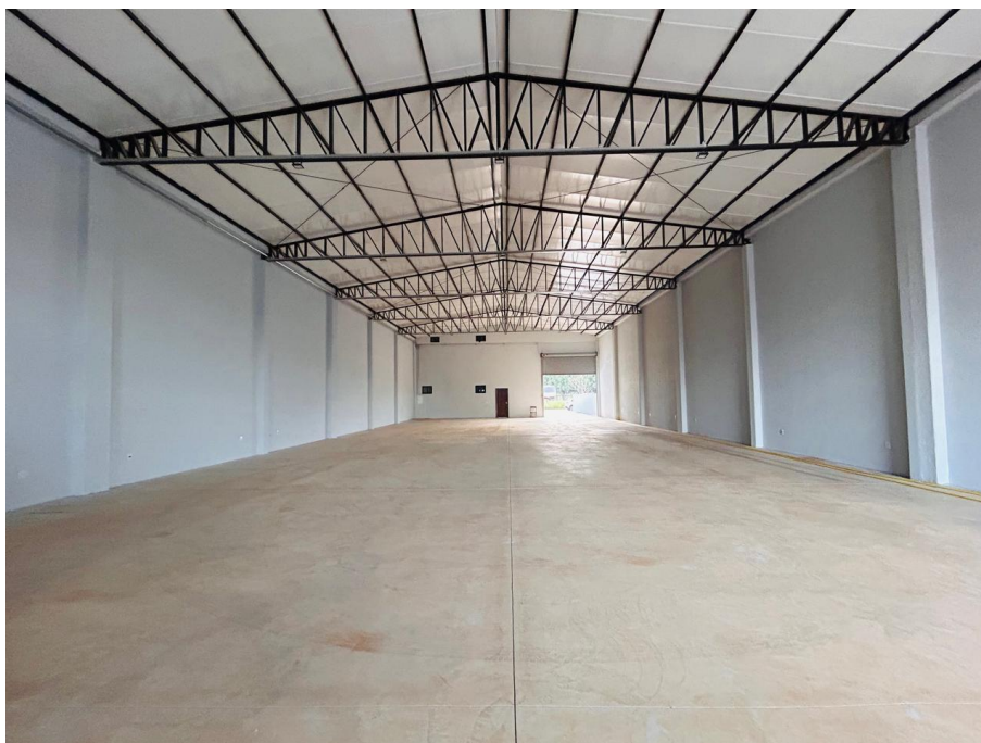
Foto 8. Prédio para locação da vistoria veicular da CRT em Sinop/ MT – Pavimento térreo - Área do barracão - Vista do barracão a partir do fundo da edificação. Foto em 04/02/2026.
