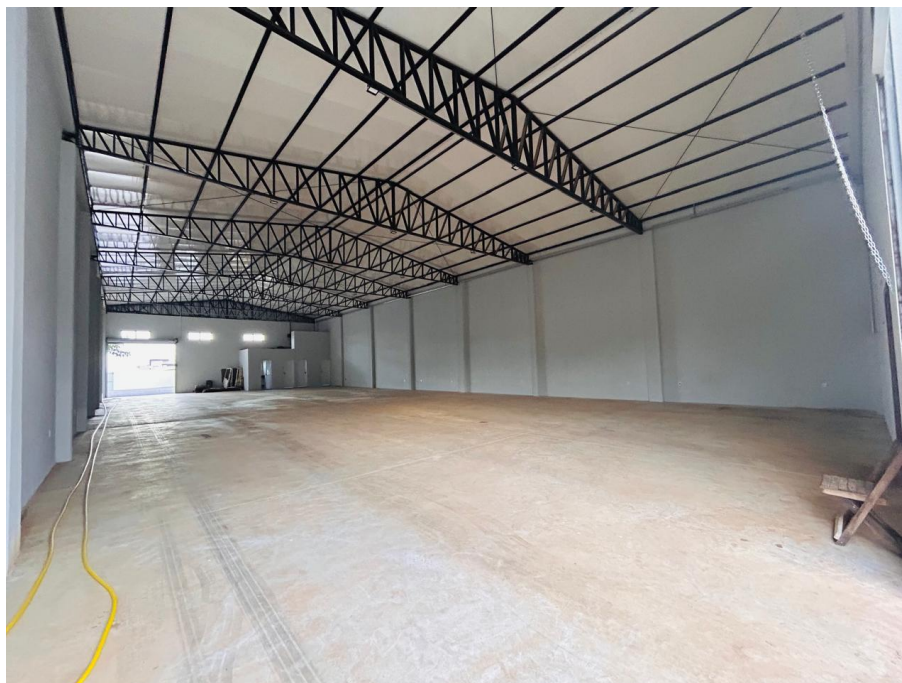
Foto 7. Prédio para locação da vistoria veicular da CRT em Sinop/ MT – Pavimento térreo - Área do barracão - Vista do barracão a partir do portão de acesso frontal da edificação Foto em 04/02/2026.
