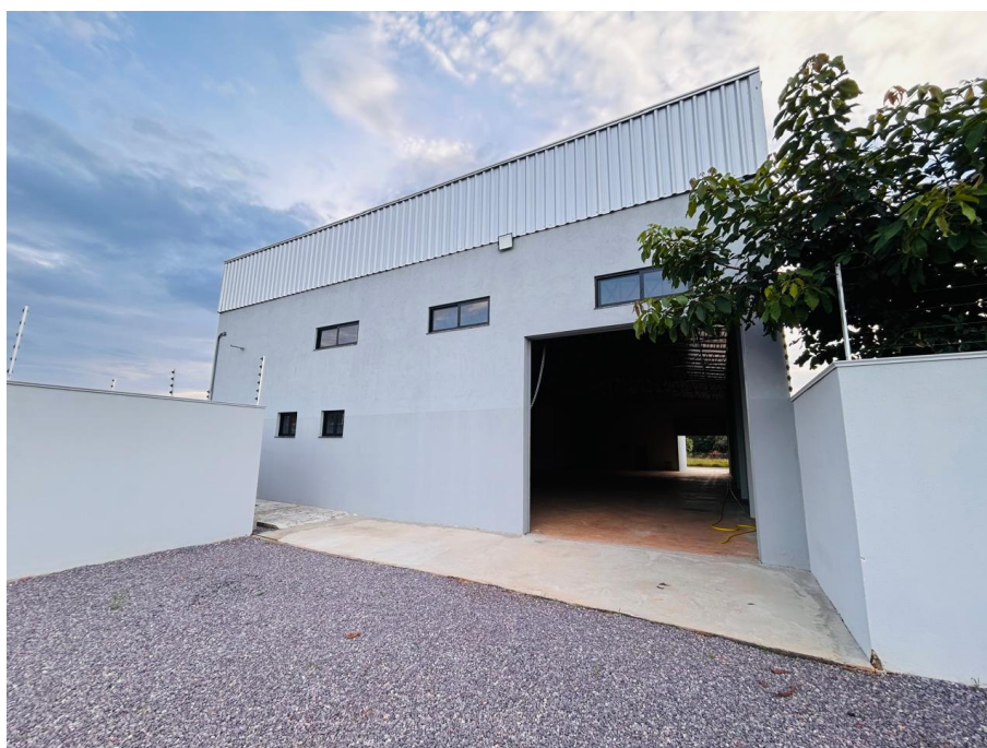
Foto 13. Prédio para locação da vistoria veicular da CRT em Sinop/ MT – Vista do fundo da edificação. Foto em 04/02/2026.
