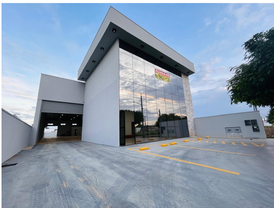
Foto 3. Prédio para locação da vistoria veicular da CRT em Sinop/ MT – Vista da fachada a partir do passeio do imóvel. Foto em 04/02/2026.
