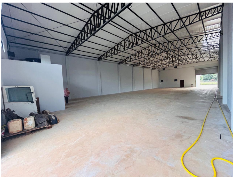
Foto 9. Prédio para locação da vistoria veicular da CRT em Sinop/ MT – Pavimento térreo - Área do barracão Vista do barracão a partir do fundo da edificação. Foto em 04/02/2026.
