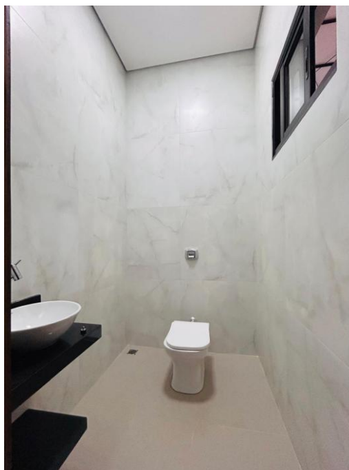
Foto 20. Prédio para locação da vistoria veicular da CRT em Sinop/ MT – Pavimento térreo - Vista do banheiro da sala térrea. Foto em 04/02/2026.
