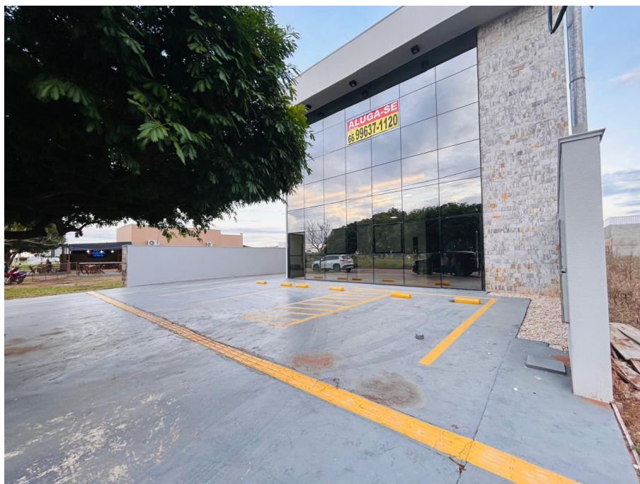
Foto 4. Prédio para locação da vistoria veicular da CRT em Sinop/ MT – Vista da fachada a partir do passeio do imóvel. Foto em 04/02/2026.
