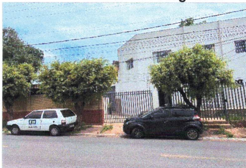
Foto 1. Fachada da edificação.
