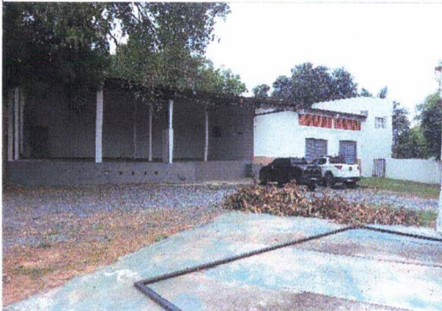
Foto 15. Pátio Acesso lateral
