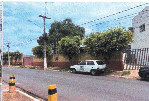
Foto 2. Fachada e lateral esquerda da edificação.
