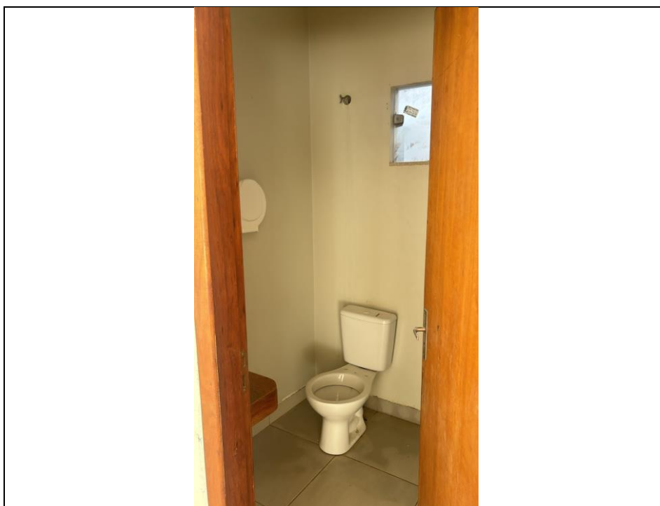
Foto 9. Imóvel em Comodoro/ MT – Vista da sala DML do imóvel a partir da porta de acesso. Foto em 17/07/2025.
