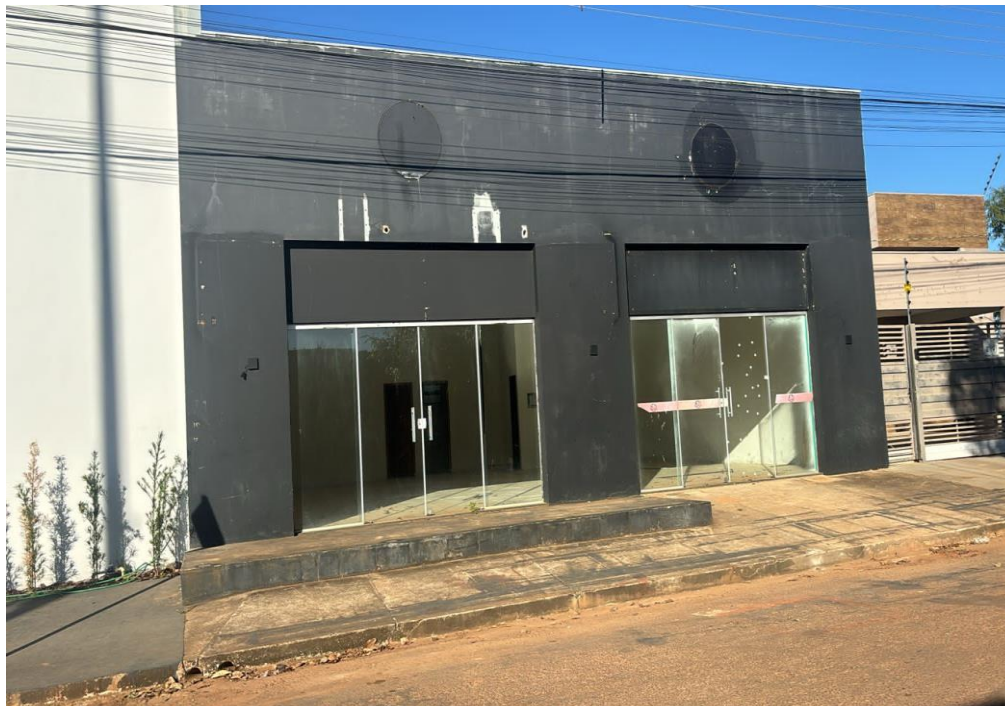
Foto 1. Imóvel em Comodoro/ MT – Vista frontal da edificação a partir do logradouro. Foto em 17/07/2025.
