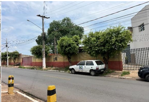
Foto 2. Fachada e lateral esquerda da edificação.
