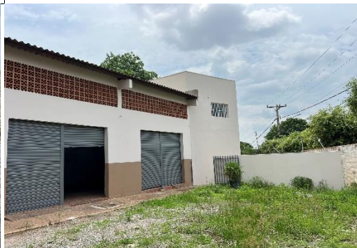
Foto 14. Portão de acesso lateral.
