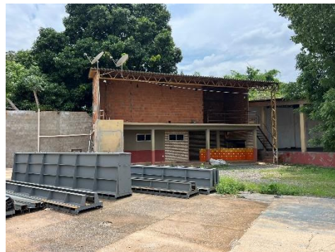
Foto 12. Edicula fundos pátio - banheiros e cozinha térreo
