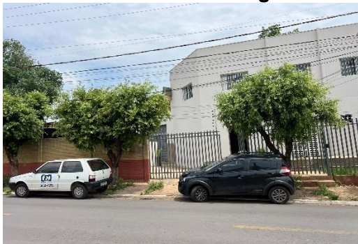
Foto 1. Fachada da edificação.
