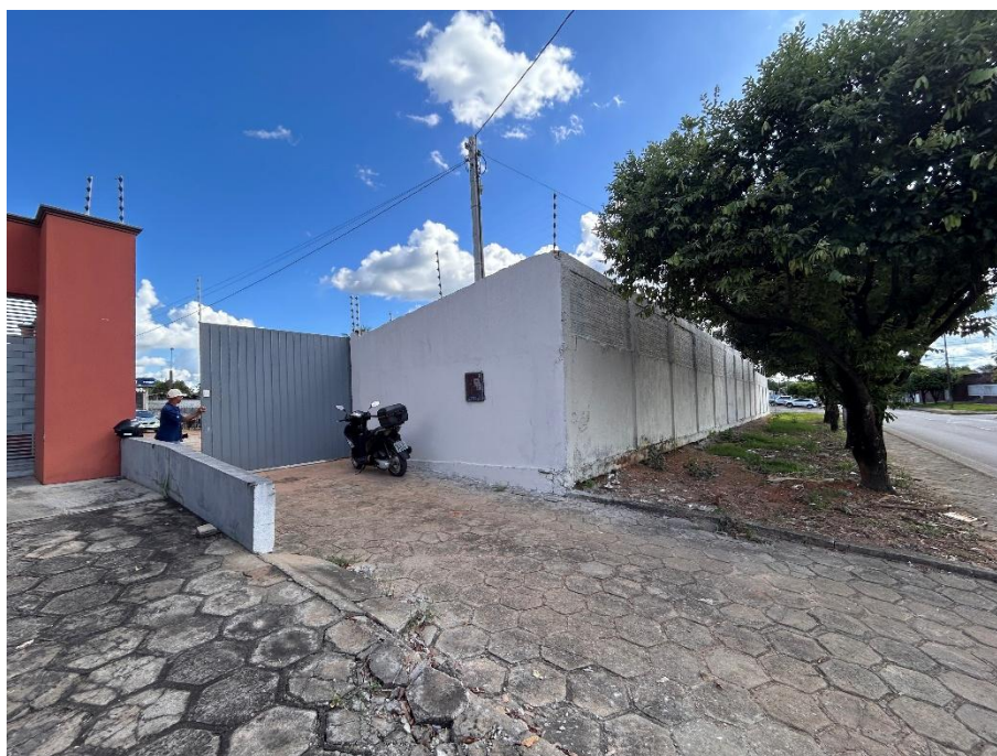
Foto 2. Pátio de Apreensão em Alta Floresta – Vista da fachada a partir do logradouro. Foto em 06/05/2025.
