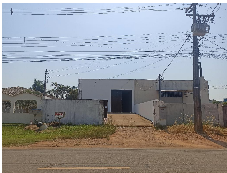
Foto 2. Prédio para Locação em Alta Floresta – Vista da fachada a partir do logradouro. Foto em 15/11/2023.
