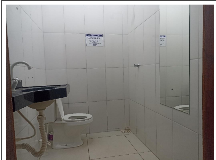
Foto 12. Prédio para Locação em Alta Floresta – Vista do BWC 02 a partir da porta de acesso. Foto em 15/11/2023.
