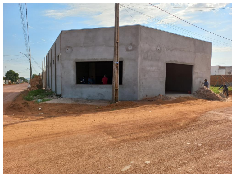
Prédio 61ª. CRT Confresa – Fachada. Prédio onde funcionará a CRT
