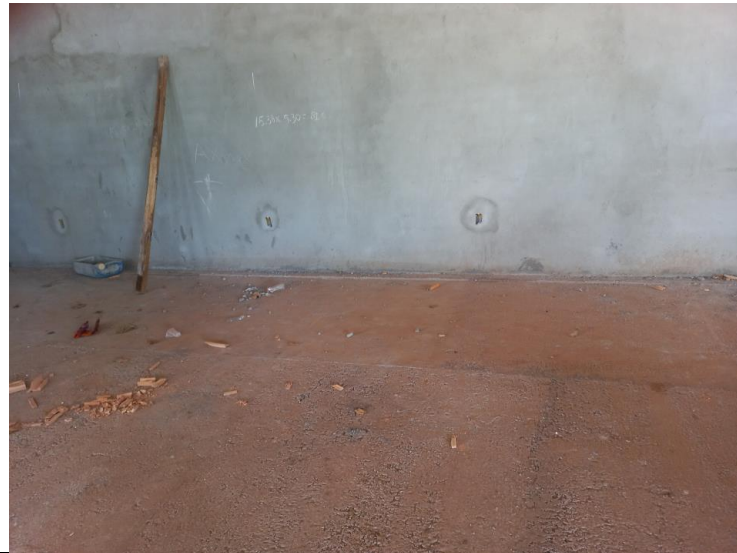
Prédio 61ª. CRT Confresa – instalações elétricas
