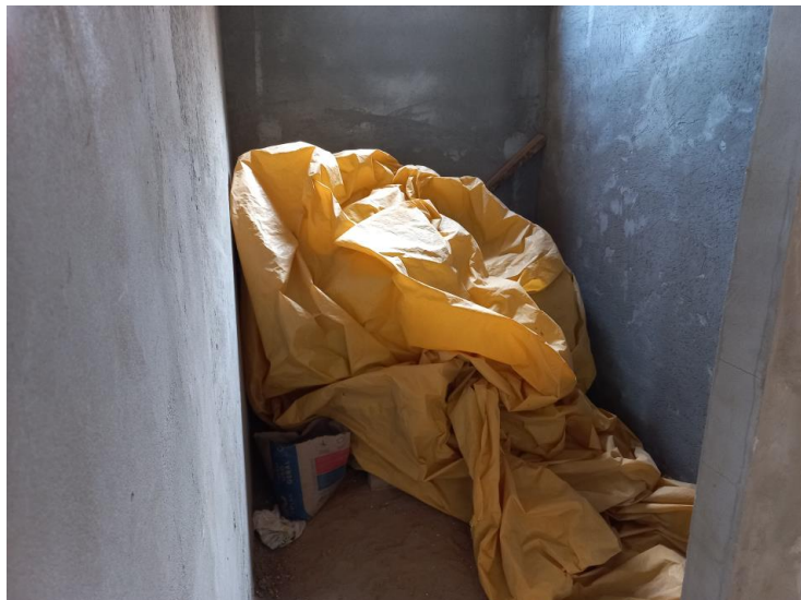
Prédio 61ª. CRT Confresa – futuras instalações de WC
