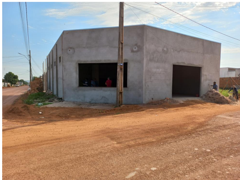
Prédio 61ª. CRT Confresa – Fachada. Foto 18/10/2023.
