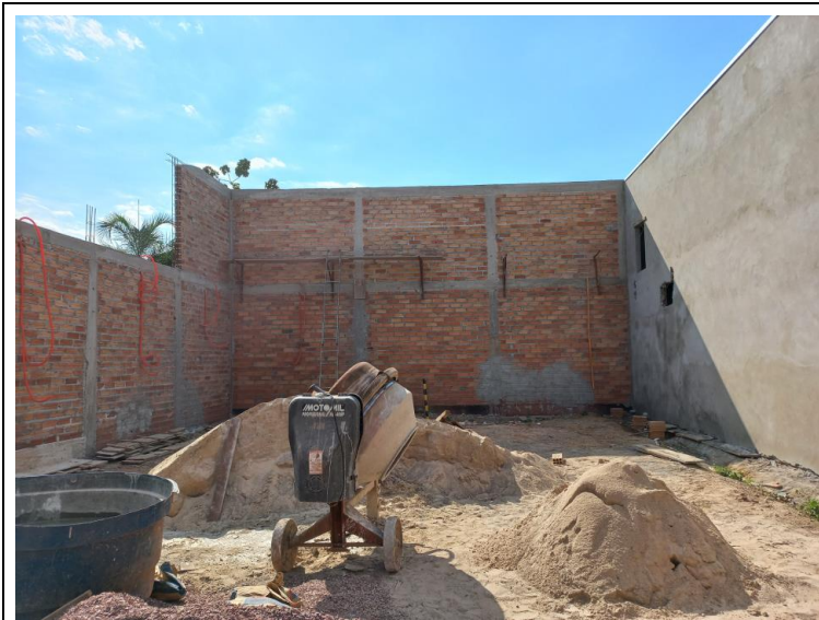
Prédio 61ª. CRT Confresa – futura Vistoria Veicular
