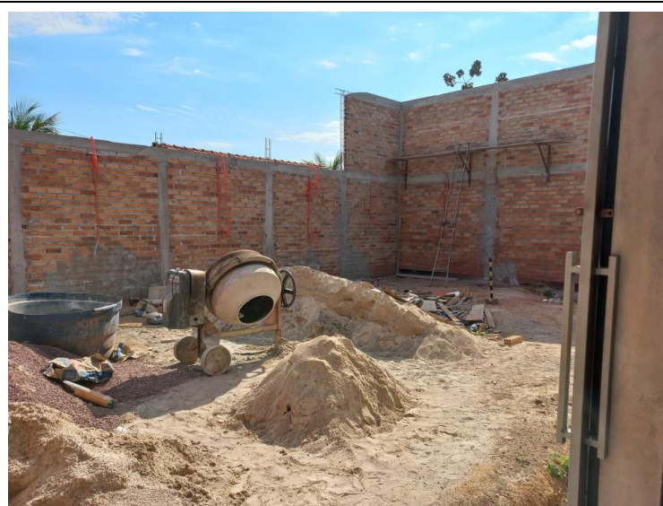
Prédio 61ª. CRT Confresa – futura Vistoria Veicular
