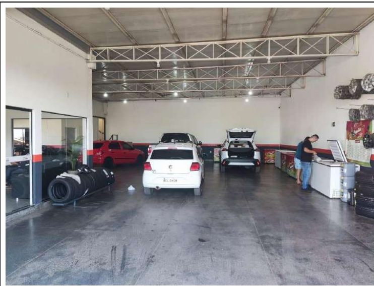
Foto 5. Prédio para locação em Jaciara – Vista do salão a partir da porta de entrada. Foto em 27/07/2023.
