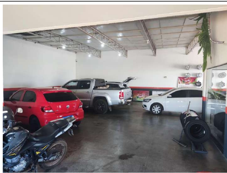
Foto 11. Prédio para locação em Jaciara – Vista do salão a partir da porta do banheiro PCD. Foto em 27/07/2023.
