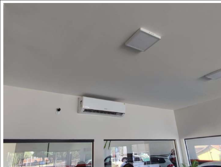
Foto 22. Prédio para locação em Jaciara – Vista da do forro do atendimento. Foto em 27/07/2023.
