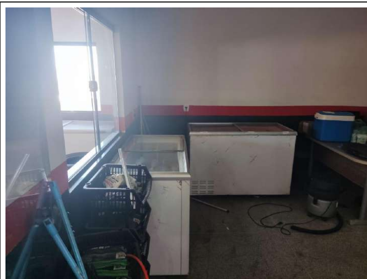
Foto 13. Prédio para locação em Jaciara – Vista da sala de depósito. Foto em 27/07/2023.
