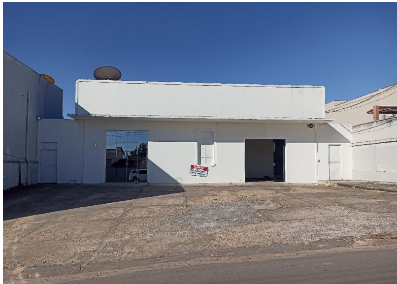
Foto 1. Prédio para locação em Diamantino/ MT – Vista frontal da edificação a partir do logradouro. Foto em 30/06/2023.
