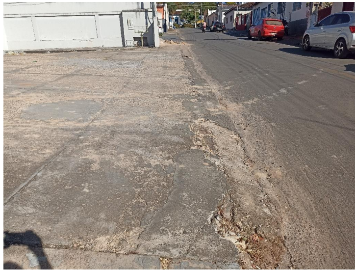
Foto 4. Prédio para locação em Diamantino/ MT – Vista do passeio da edificação. Foto em 30/06/2023.
