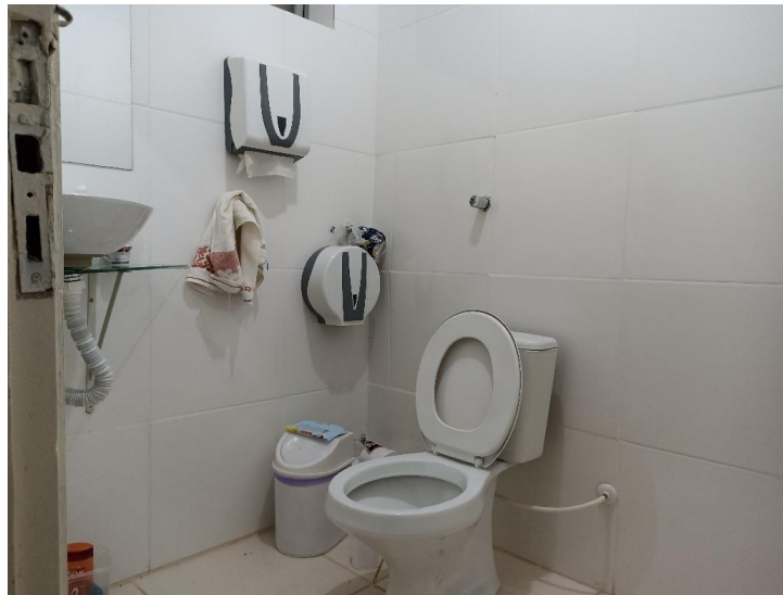
Foto 16. Prédio para locação em Diamantino/ MT – Vista do BWC 02 a partir da porta de acesso. Foto em 30/06/2023.
