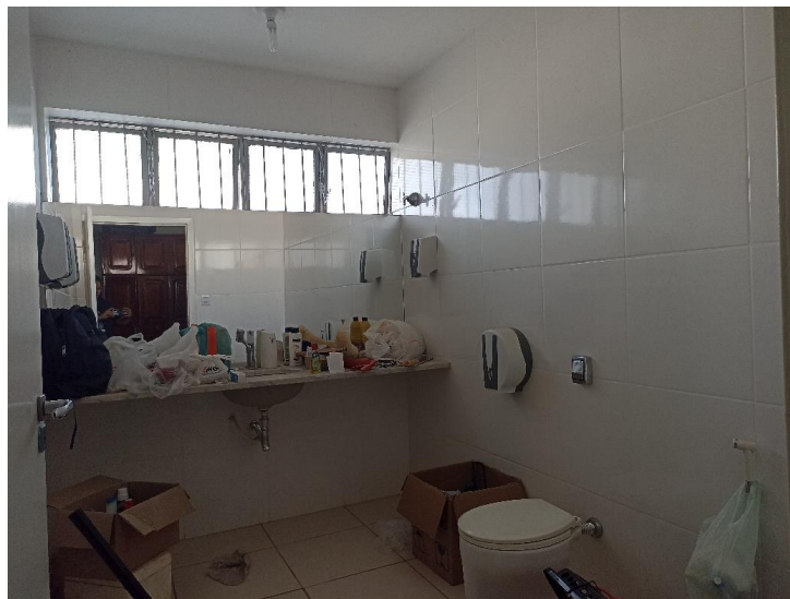
Foto 15. Prédio para locação em Diamantino/ MT - Vista do BWC 03 a partir da porta de acesso. Foto em 30/06/2023.
