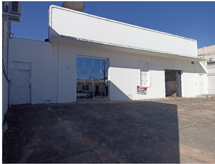
Foto 2. Prédio para locação em Diamantino/ MT – Vista da fachada do imóvel a partir do passeio. Foto em 30/06/2023.
