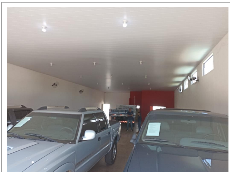
Foto 6. Prédio para Locação em Guiratinga – Sala de Atendimento/ Vistoria/ Arquivo - Vista da edificação a partir da porta de acesso do prédio. Foto em 24/11/2022.
