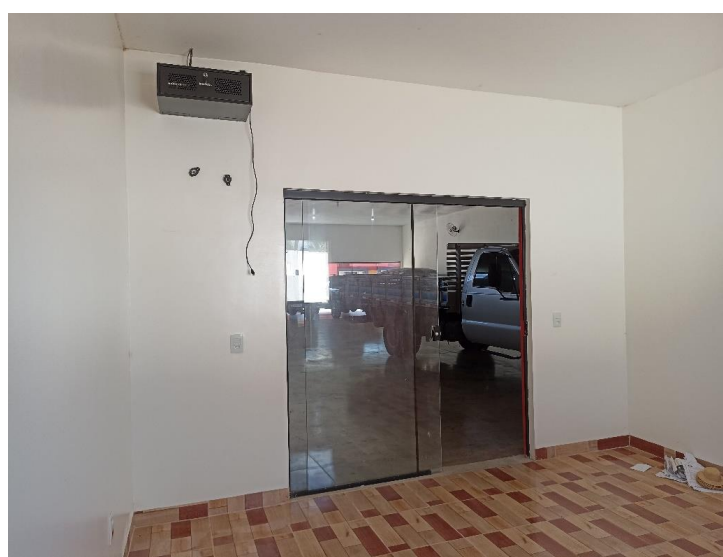
Foto 9. Prédio para Locação em Guiratinga – Sala de Provas. Foto em 24/11/2022.
