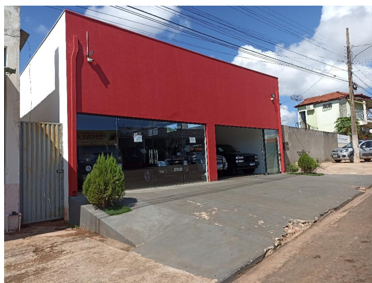
Foto 2. Prédio para Locação em Guiratinga – Vista da fachada a partir do logradouro. Foto em 24/11/2022.
