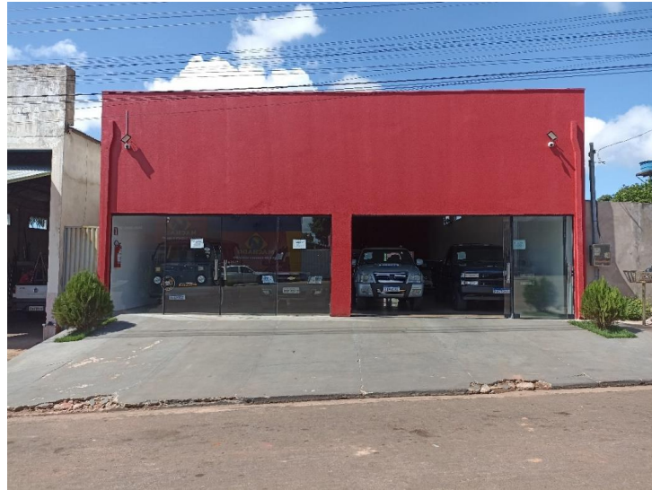
Foto 1. Prédio para Locação em Guiratinga – Vista da fachada a partir do logradouro. Foto em 13/09/2022.
