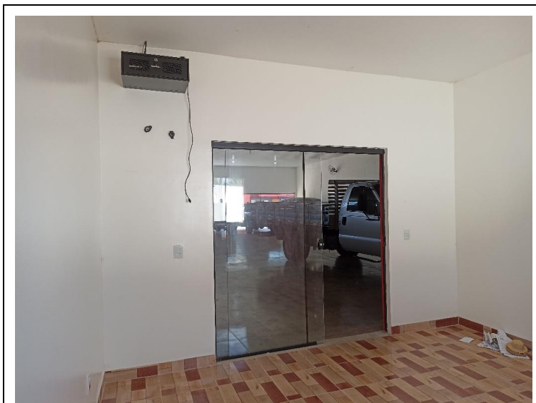
Foto 9. Prédio para Locação em Guiratinga – Sala de Provas. Foto em 24/11/2022.
