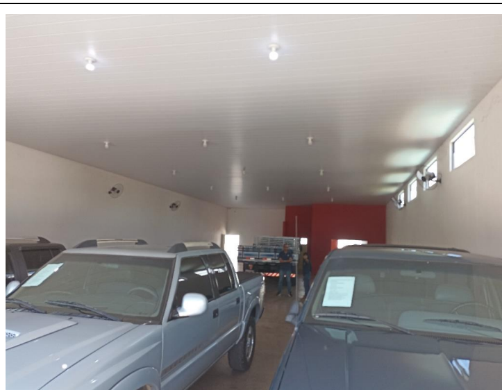
Foto 6. Prédio para Locação em Guiratinga – Sala de Atendimento/ Vistoria/ Arquivo - Vista da edificação a partir da porta de acesso do prédio. Foto em 24/11/2022.
