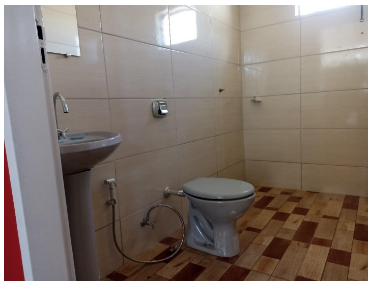
Foto 11. Prédio para Locação em Guiratinga – Banheiro Multiuso. Foto em 24/11/2022.
