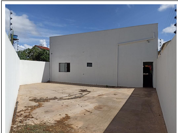
Foto 16. Prédio para Locação em Guiratinga – Pátio no fundo da edificação. Foto em 24/11/2022.
