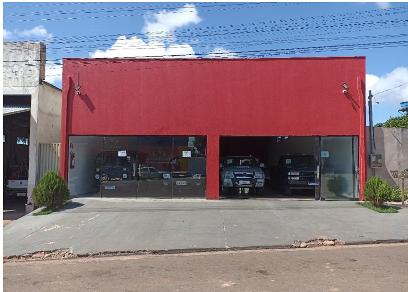
Foto 1. Prédio para Locação em Guiratinga – Vista frontal da edificação a partir do logradouro. Foto em 24/11/2022.
