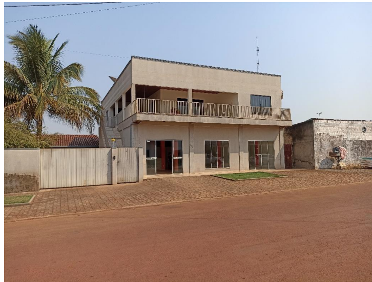
Foto 1. Prédio para locação em Brasnorte – Pavimento Térreo - Vista da fachada a partir do logradouro. Foto em 01/09/2022.
