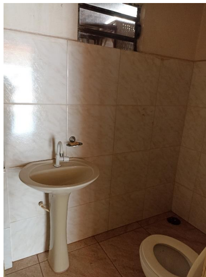
Foto 16. Prédio para locação em Brasnorte – Pavimento Térreo – Vista do Banheiro destinado aos servidores. Foto em 01/09/2022.
