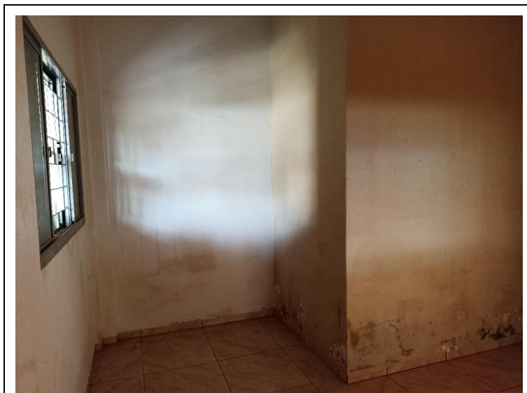
Foto 10. Prédio para locação em Brasnorte – Pavimento Térreo – Sala de Provas - Vista do interior. Foto em 01/09/2022.
