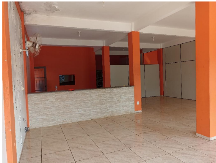
Foto 2. Prédio para locação em Brasnorte – Pavimento Térreo – Sala de Atendimento - Vista da edificação a partir da porta de acesso ao prédio. Foto em 01/09/2022.
