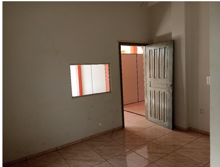
Foto 17. Prédio para locação em Brasnorte – Pavimento Térreo – Copa. Foto em 01/09/2022.
