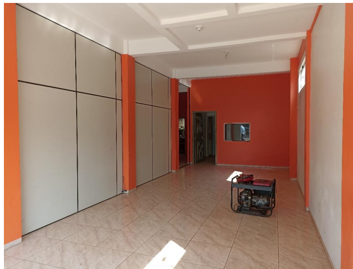
Foto 14. Prédio para locação em Brasnorte – Pavimento Térreo – Sala de Arquivo. Foto em 01/09/2022.
