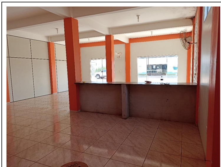
Foto 6. Prédio para locação em Brasnorte – Pavimento Térreo – Vista da Sala de Atendimento a partir do Hall de Circulação. Foto em 01/09/2022.
