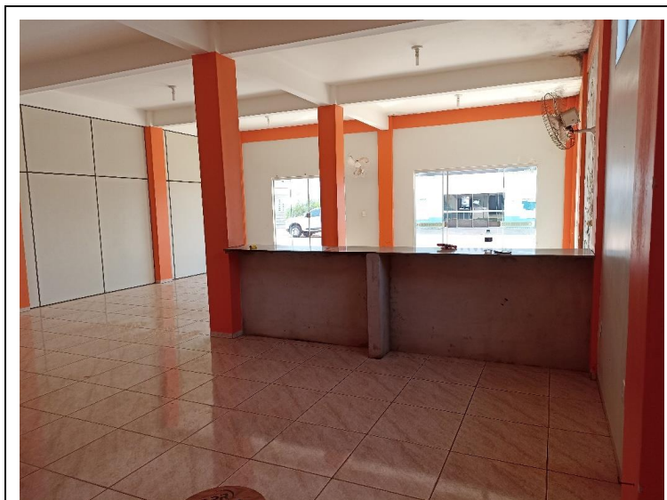
Foto 7. Prédio para Locação em Brasnorte – Pavimento Térreo – Vista da Sala de Atendimento a partir do Hall de Circulação. Foto em 01/09/2022.
