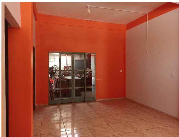
Foto 9. Prédio para Locação em Brasnorte – Pavimento Térreo – Vista da porta de acesso a área residencial nos fundos da edificação que deverá ser vedado em alvenaria. Foto em 01/09/2022.
