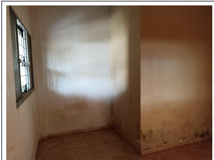
Foto 11. Prédio para Locação em Brasnorte – Pavimento Térreo – Sala de Provas - Vista do interior. Foto em 01/09/2022.
