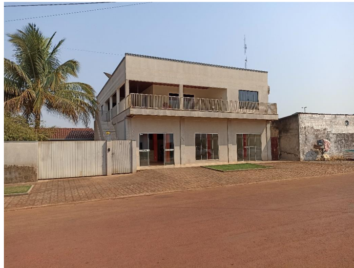
Foto 2. Prédio para Locação em Brasnorte – Pavimento Térreo - Vista da fachada a partir do logradouro. Foto em 01/09/2022.
