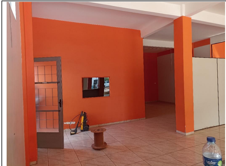
Foto 6. Prédio para Locação em Brasnorte – Pavimento Térreo – Hall de Circulação. Foto em 01/09/2022.
