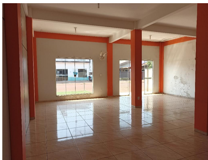
Foto 4. Prédio para Locação em Brasnorte – Pavimento Térreo – Sala de atendimento - Vista do interior da edificação. Foto em 01/09/2022.
