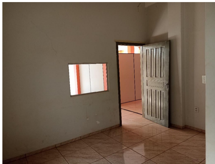
Foto 18. Prédio para Locação em Brasnorte – Pavimento Térreo – Copa. Foto em 01/09/2022.
