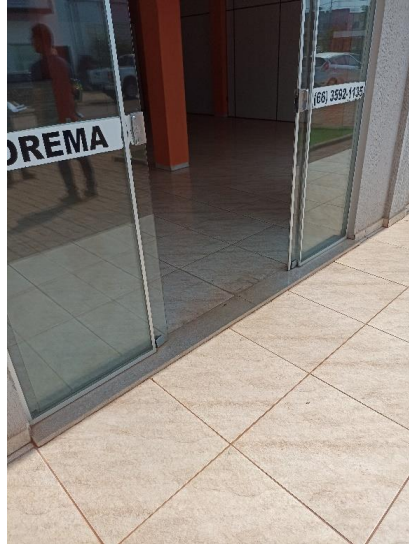
Foto 22. Prédio para Locação em Brasnorte – Pavimento Térreo – Fachada da Edificação - Vista da porta de acesso a sala de atendimento ao público. Foto em 01/09/2022.
