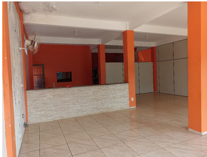
Foto 3. Prédio para Locação em Brasnorte – Pavimento Térreo – Sala de Atendimento - Vista da edificação a partir da porta de acesso ao prédio. Foto em 01/09/2022.
