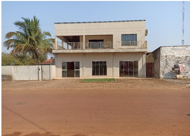
Foto 1. Prédio para Locação em Brasnorte – Pavimento Térreo -Vista frontal da edificação a partir do logradouro. Foto em 01/09/2022.
