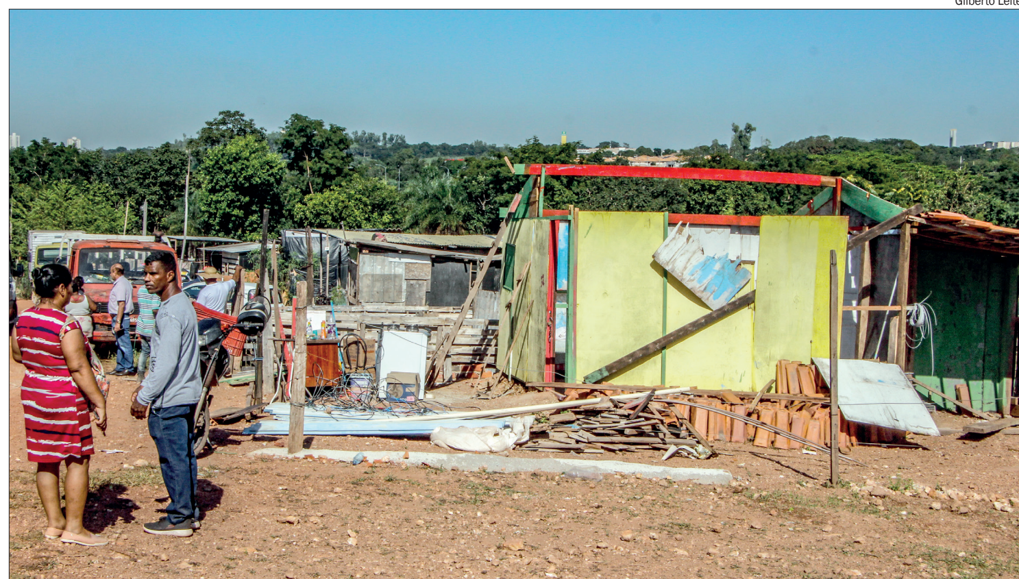
A Justiça determinou o cumprimento do mandado de desocupação da área, com autorização para demolição de algumas edificações
