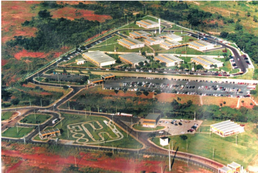
Figura 2: Blocos da sede do DETRAN/MT em Out/2000.
